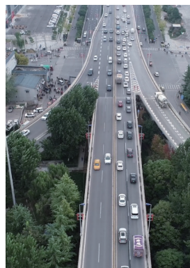
图1 半坡立交主线道路不匹配
