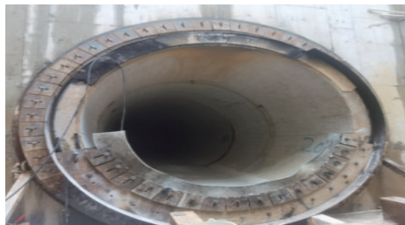
图5 洞口止水安装图
