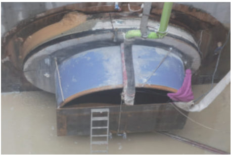
图10 管道两端封堵现场照片
