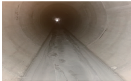
图4 流态固化土固化后状态
