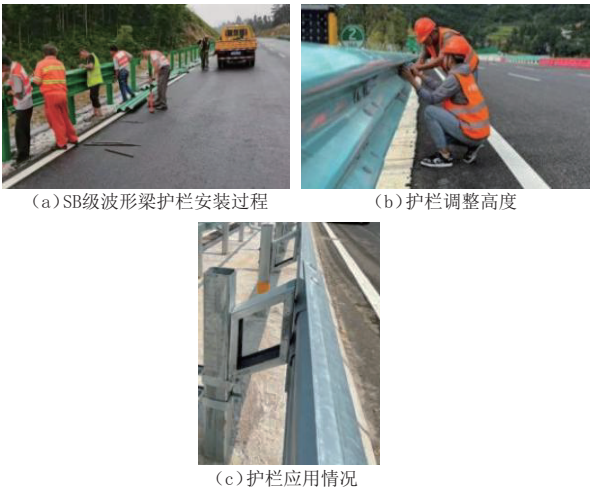
图14 护栏安装及应用照片
