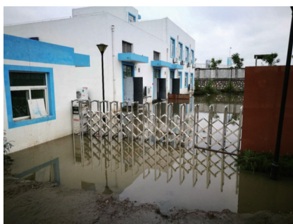
图1 雨后泵站积水照片
