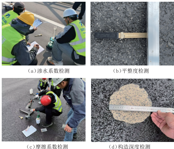
图14 铺装施工效果和质量检测
