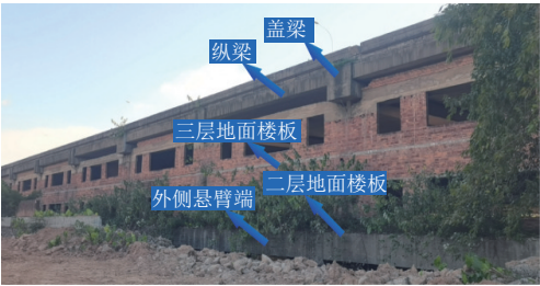
图2 互通商业桥主体结构
