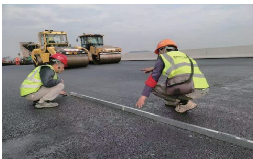
图2 接缝位置平整度控制
