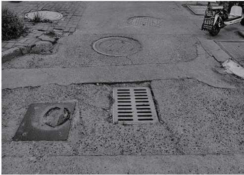
图 2 雨水口接入污水管道
