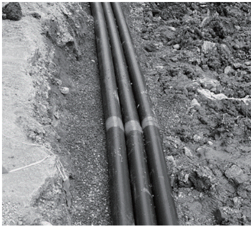
图7 新建PE套管照片
