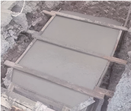
图5 承台加固现场图
