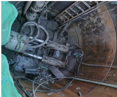
图4 始发井顶管安装图
