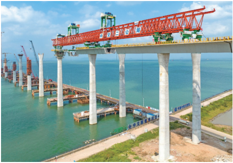
图 16 节段梁多节段悬拼现场照片
