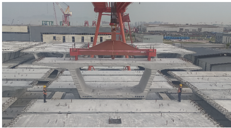
图 13 节段梁吊梁、存梁现场照片
