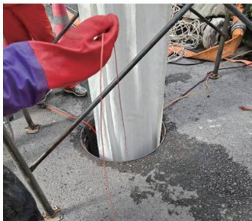
图3 光纤置入管道过程
