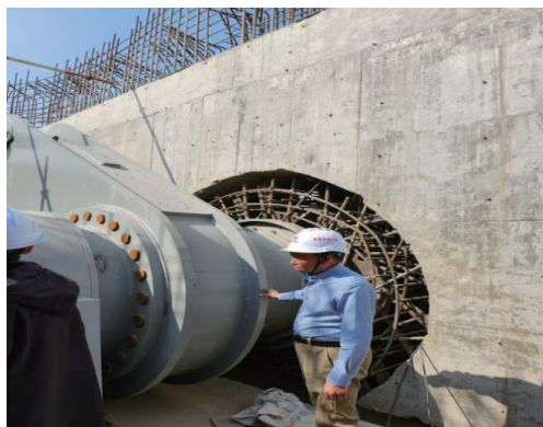
图4 底轴穿墙零泄漏现场施工图
