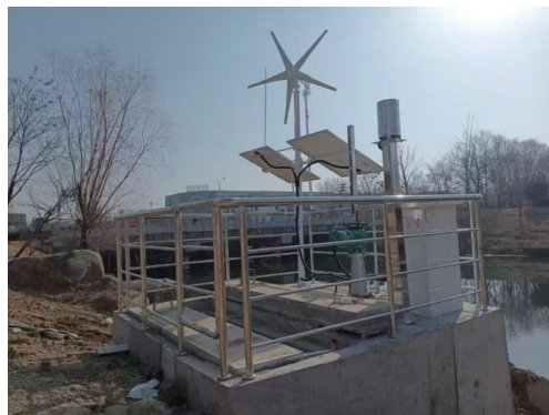
图5 利用太阳能自动化无人值守液压钢坝闸驱动装置外观图
