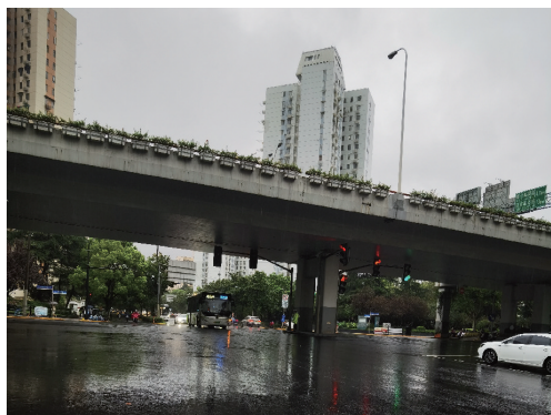
图2 内环高架更新前实景
