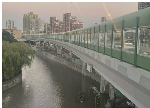
图3 内环高架更新后实景
