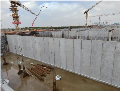
(b) 现场施工照片
