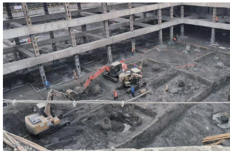
图13 基坑坑底土体情况及工作人员行动
