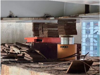
图 16 顶升过程中千斤顶与临时支撑交替加高
