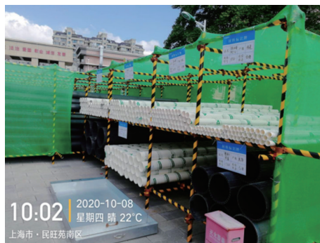
图1 分类标识、堆放雨、污水管
