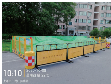
图2 用绿网覆盖裸土
