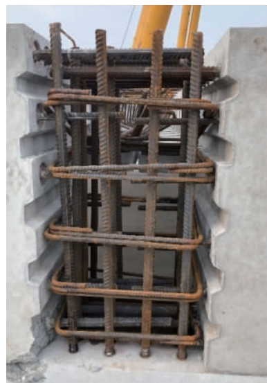
图 2 梁-柱节点
