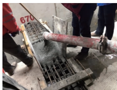
图11 梁-柱接头浇筑
