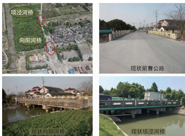
图 4 前曹公路桥桥址现状之实景
