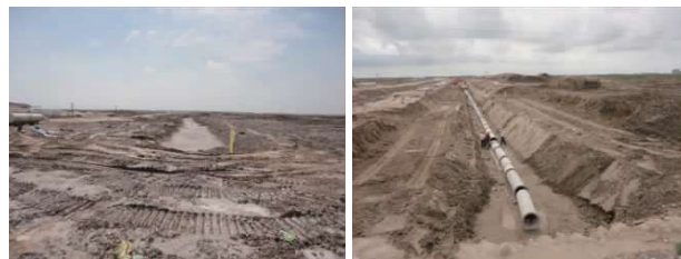
图6 井点降水前后现场土质情况
