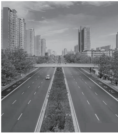
图6 银莺路人行过街天桥实景
