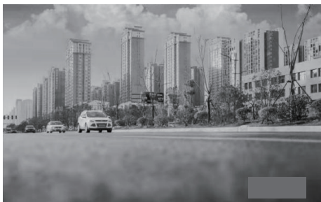
图 7 航海路建筑立面实景
