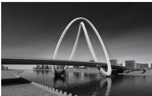
图1 独塔斜拉桥桥梁方案图
