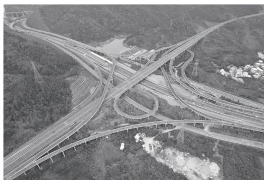
图 15 珠田枢纽互通立交
