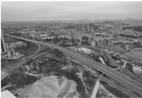
图 17 惠南立交现场实景
