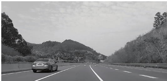
图 21 植物遮挡边坡桥梁痕迹之实景
