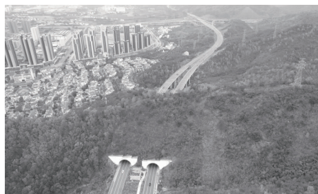
图3 途经西湖风景名胜区外侧段桥隧之实景
