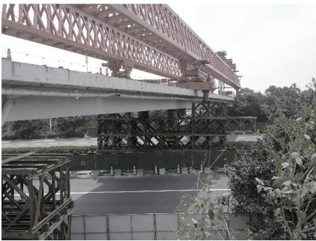
(a)架桥机架设完成图
