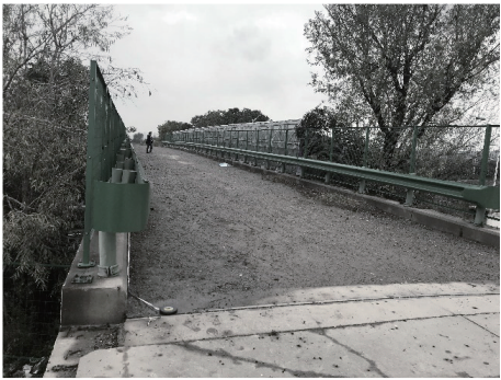
图3 现状桥梁桥面照片
