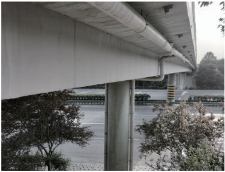
图2 现状桥梁侧面照片
