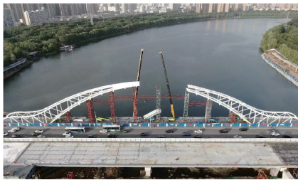
图 10 慢行桥拱圈吊装施工现场图
