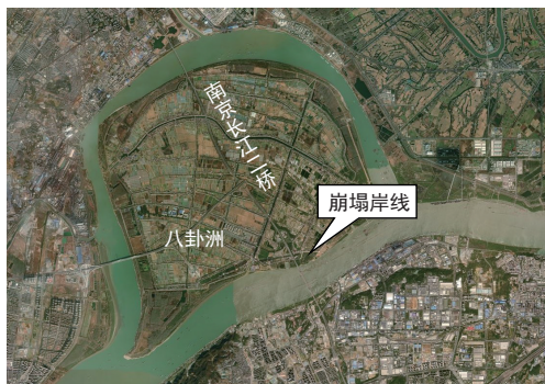
图1 八卦洲天河口段崩岸位置
