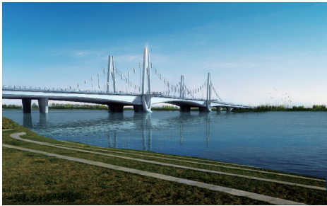
图 1 双塔自锚式悬索桥效果图
