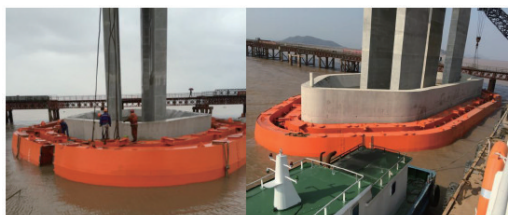
图15 浮箱连接作业示意图
