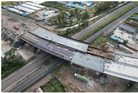
图8 顶推施工现场图
