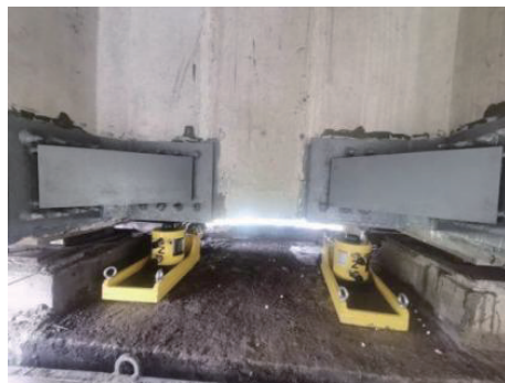
图3 横隔板加固装置
