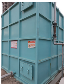
图 10 生物滴滤系统壳体现场示意图
