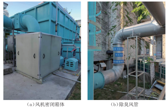
图9 除臭收集系统现场安装示意图
