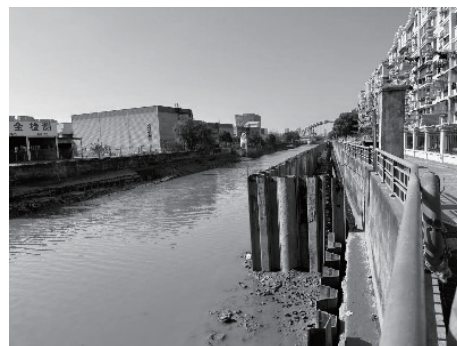
图7 现场组合桩实景运用照片
