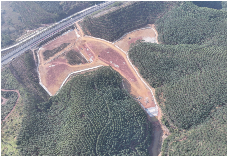
图17 处治后填平区航拍图
