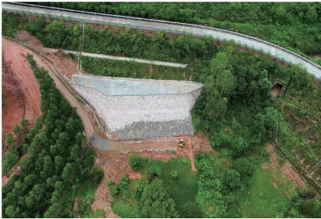
图18 处治后边坡反压护道航拍图
