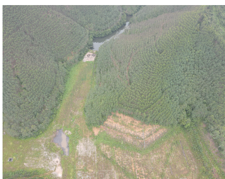
图6 填平区上游堰塞湖航拍照片
