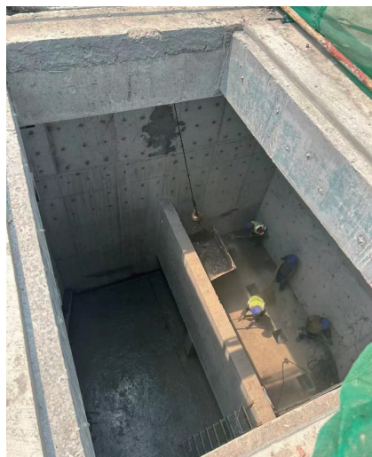
图6 泵房现场施工图
