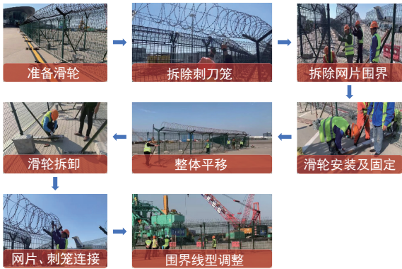
图7 临时围界移动施工的主要工序
