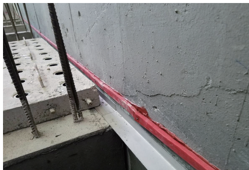
图3 遇水膨胀止水条安装
