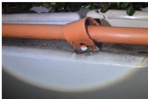
图4 花盆扁钢与固定螺栓变形
