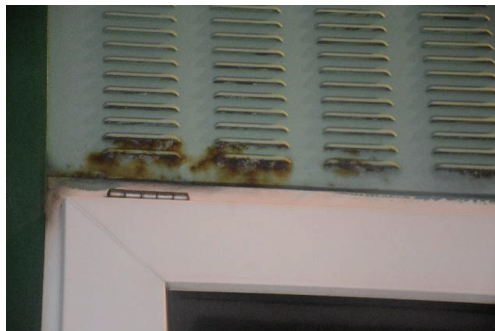
图 2 声屏障屏体锈蚀
