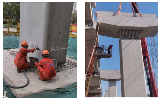
图 12 桥墩灌浆套筒连接施工
