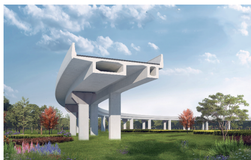
图6 匝道钢筋混凝土箱梁拼宽断面
