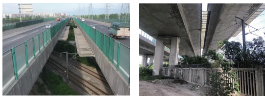
图 8 S32 公路跨沪杭客专铁路现状
