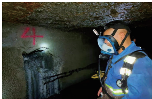
图2 大同沟分洪渠箱涵直排口现场
