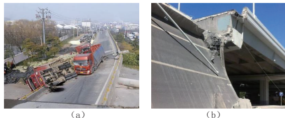
图1 桥梁倾覆事故
