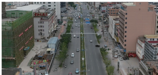
图1 现状公路航拍图
