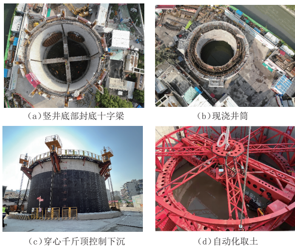
图5 1#竖井现场施工照片
