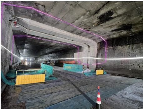
图 4 接头修复结构施工完成情况
