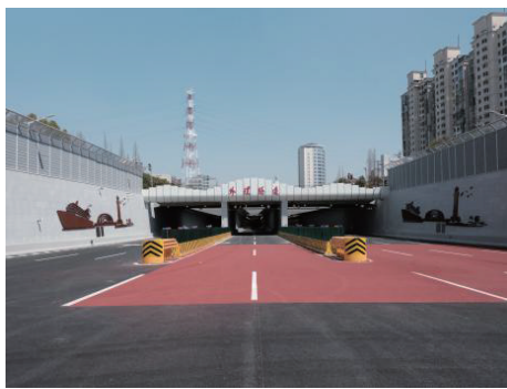
图6 外环隧道大修后门头实拍
