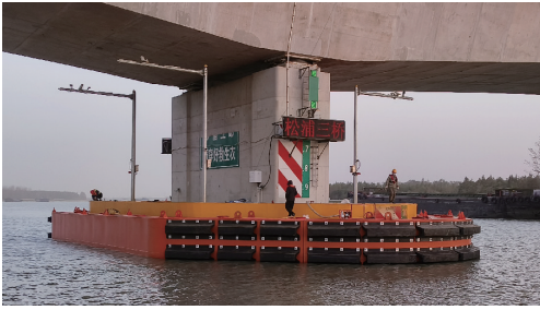
图 8 修复后的防撞设施实景
