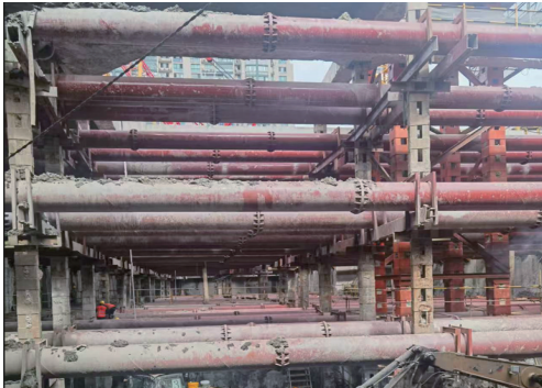
图9 A坑开挖至坑底照片
