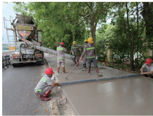
图3 混凝土抹面收光
