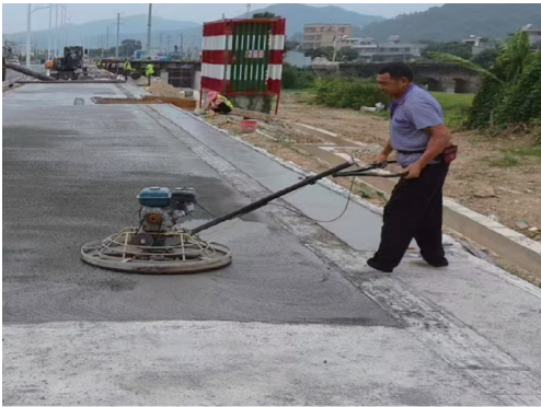
图5 混凝土面层打磨
