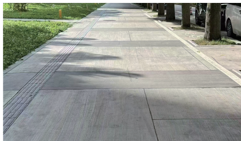
图10 意东三路拉毛混凝土人行道
