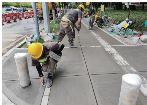
图8 深南大道拉毛混凝土人行道
