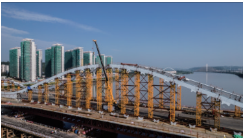
图 13 拱肋施工过程
