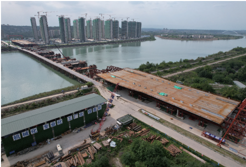
图 12 钢箱梁顶推过程
