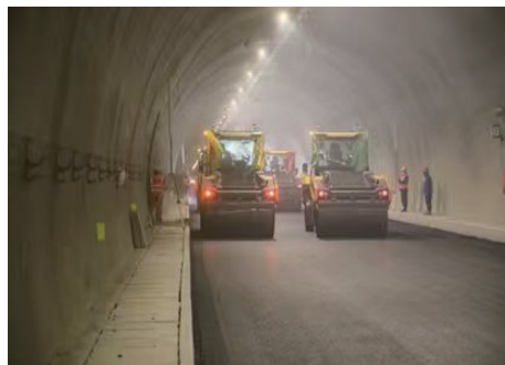
图2 隧道无人化智慧施工现场照片
