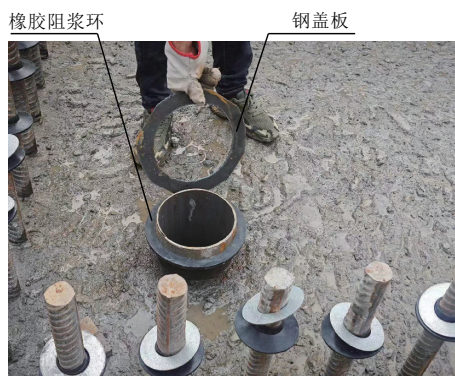
图9 立柱与承台拼接面阻浆措施
