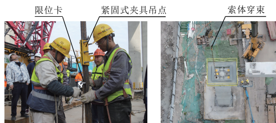
图11 索体吊点安装及索体穿束
